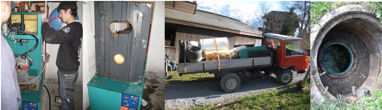
Das alte Heizsystem wird abgebaut und abtransportiert, das verbliebene Öl abgepumpt, Fotos: Leo & Angela
